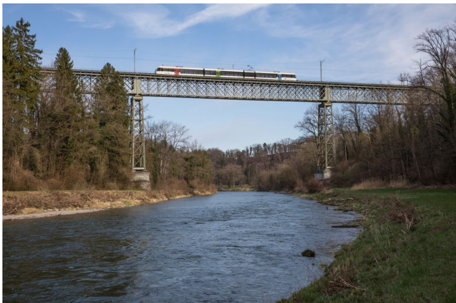
S29 Winterthur-Stein am Rhein auf der Thurbrücke bei Ossingen (Foto G. Trüb / Thurbo)
