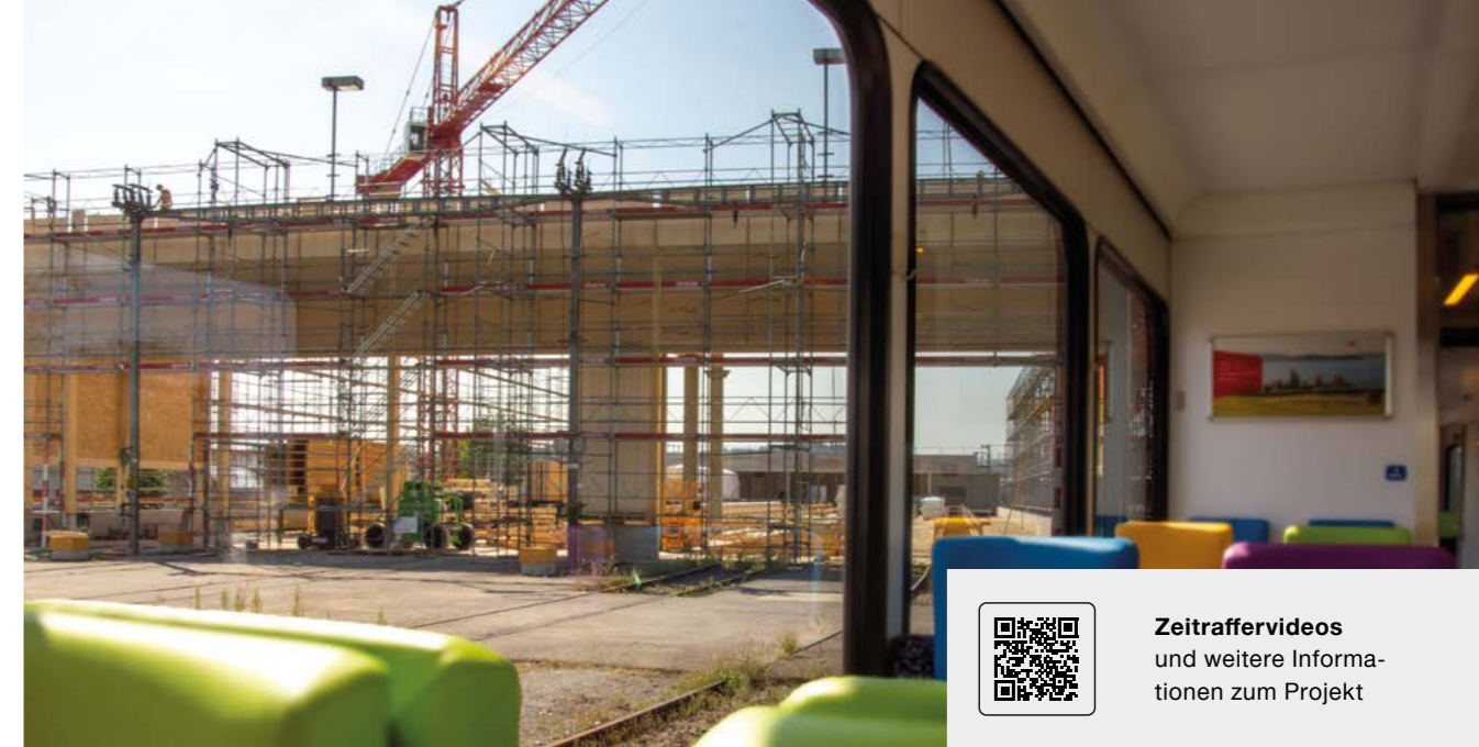
Der Holzbauer begann Ende August 2024 mit den Aufrichtarbeiten bei der Turbo Instandhaltungsanlage.
